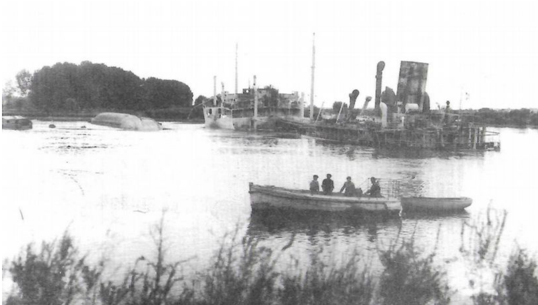
Aspect de la Loire en août 1944. Au premier plan le tanker Antarktis à gauche couchée sur le flanc la drague Pas de Calais II
